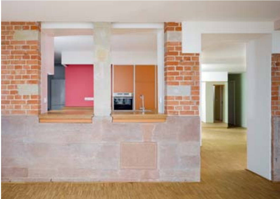
Küche und Wohnbereich trennt die Außenmauer des Gebäudes, die in ihrer Materialität nicht nur auf Wunsch des Denkmalschutzes bewusst erhalten blieb.
